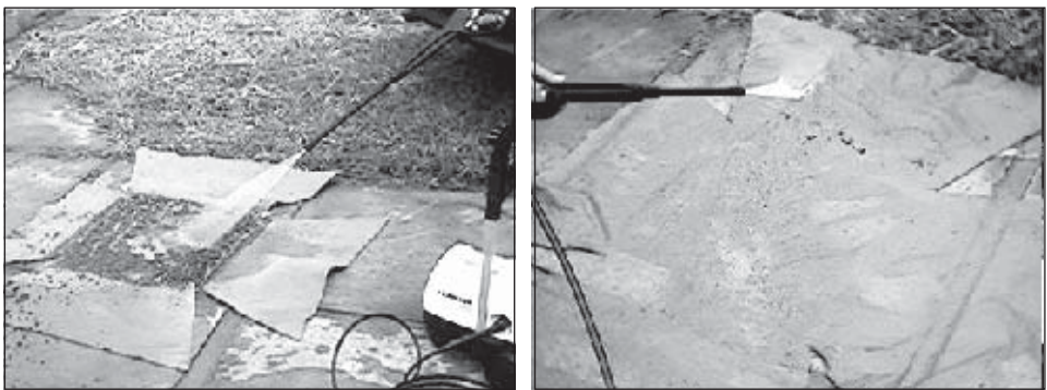
Figura 5.14 Detalhe da limpeza das mantas com jato de água de alta pressão.
